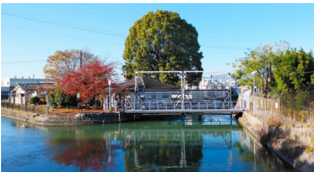
写真1 墨染発電所取水口付近(撮影:寺島俊之)
