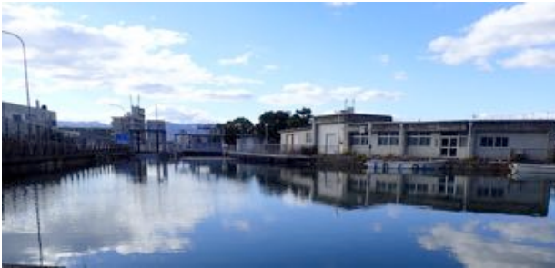
写真1 鴨川運河 伏見インクライン(上船溜)跡
