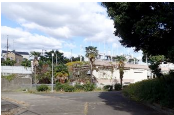
写真3 墨染発電所(1914(大正3)年竣工)
