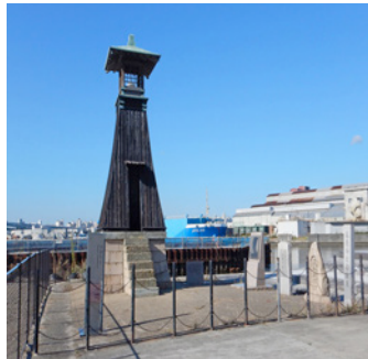
写真1 移設前の灯台(水門施工前)
