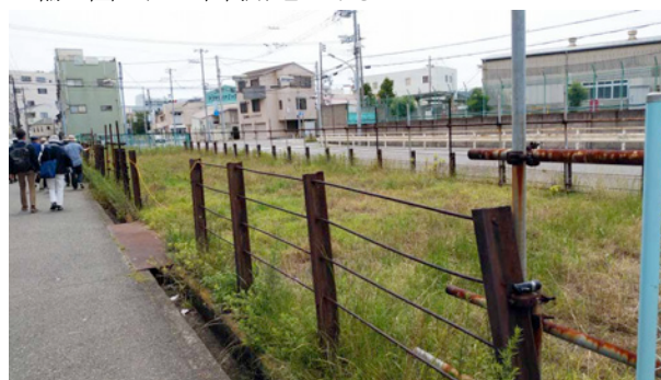
写真1 旧国鉄福知山線尼崎支線廃線跡
