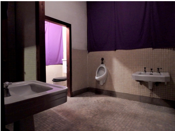
写真4 貴賓室に隣接する水洗便所
