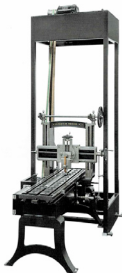
写真3 「ベルト掛け山崎旋盤」(製造者: 山崎鉄工所(現ヤマザキマザック)、1927年製造、同上より)
