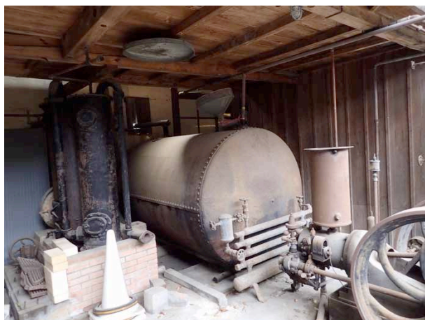
写真2 サクシヨングスエンジンシステム, 冷却用コンプレッサ, タンクなど
