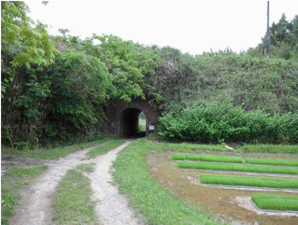
写真 3 12年前の梶ヶ谷隧道（撮影：2010/05/22） ※ 当時，周囲には田園風景が広がっていた。
