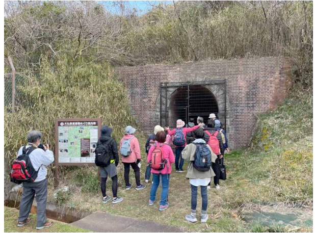
写真 4 松谷川隧道（撮影：2022/03/21） ※ 各遺構とも整備され，立派な案内板が設置されている。
