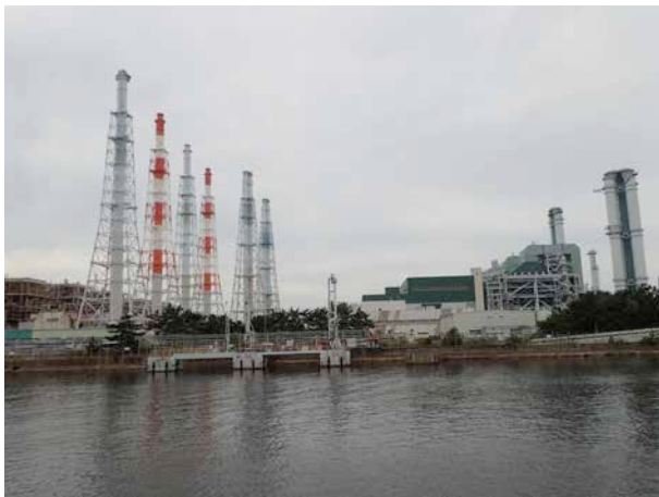
写真4 関西電力堺港発電所（撮影：2017/09/23）
