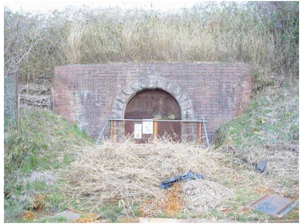
写真 5 12年前の松谷川隧道 （撮影：2010/03/30，岡田広一）
