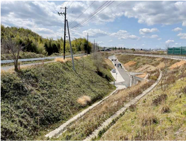
写真 2 梶ヶ谷隧道（手前側，中央付近に左側へ分岐して隧道に入る舗装道が見える）と赤橋（舗装道の向こう側先端部付近）の周辺（撮影：2022/03/21） ※ 両遺構とも撤去されて道路が建設される計画であったが，道路は両遺構を避ける形で右側に大きく湾曲して建設された。
